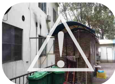
煤气房离厨房太近 不安全
